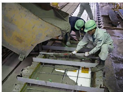
④コンクリート打設
