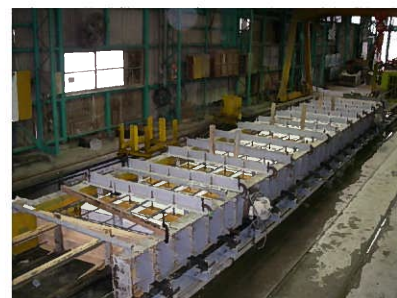
③型枠組立
