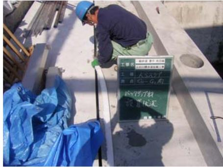
写真-13 バックアップ材設置
