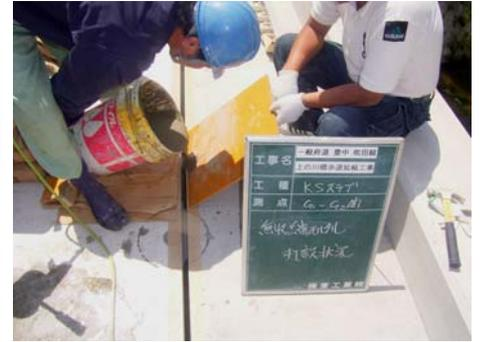
写真 14 無収縮モルタル打設
