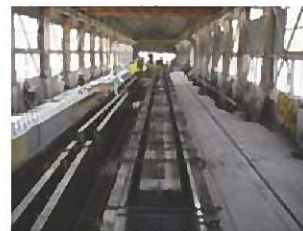
写真-3 型枠建て込み後
