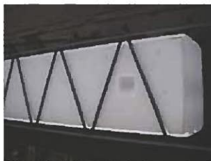
写真-1 トラス筋と EPS
