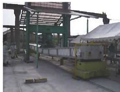
写真-9 載荷試験状況
