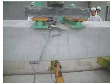
写真-8 破壊状況
