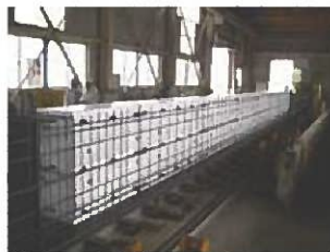
写真-2 配筋状況
