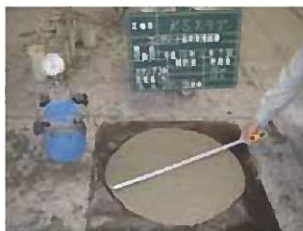
写真-4 コンクリート品質管理
