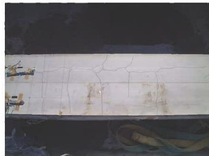
写真-7 載荷試験前のひび割れ
