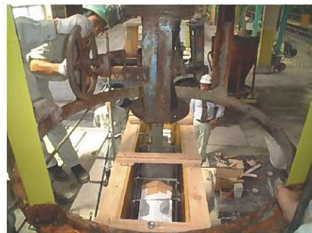
写真-13 打設性能試験状況 (その2)
