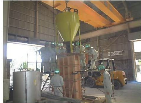
写真-12 打設性能試験状況 (その1)
