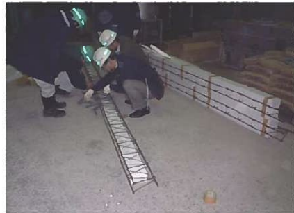
写真-4 EPS組立状況
