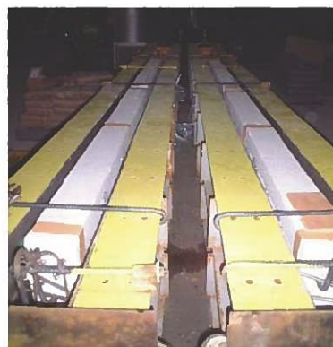
写真-5 型枠組立完了
