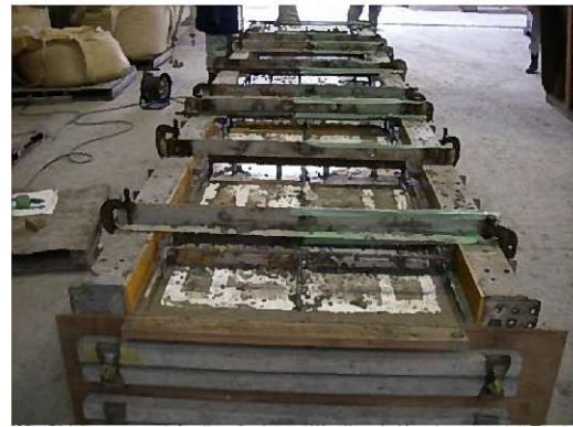
写真 7.2 コンクリート打設
