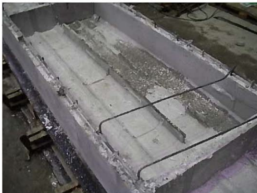
写真 7.3 充填確認 (スリットあり)
