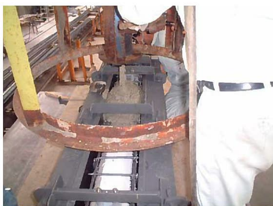
写真 2.3 高流動コンクリート打設状況
