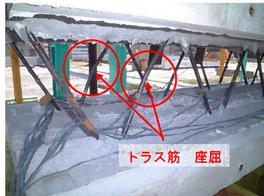
写真 4.2 破壊状況 (トラス筋の座屈)
