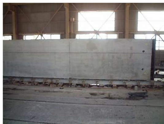
写真 2.4 脱枠後の製品
