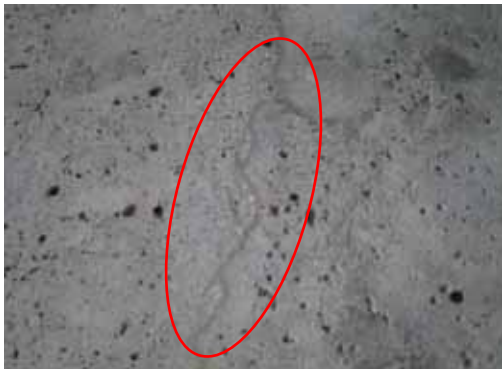
図-5 ひび割れ注入跡の状況
