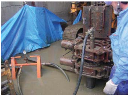
段階加圧注入状況
