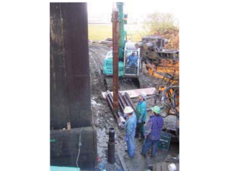
鋼管吊込み状況
