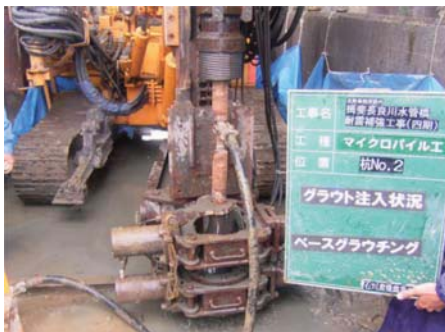
ベースグラウチング状況
