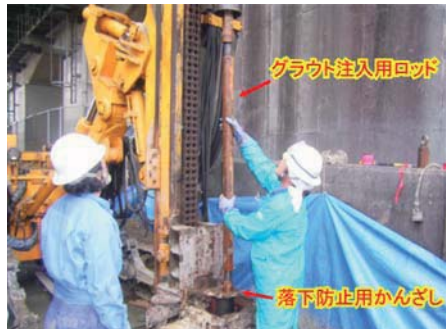
注入用ロッド接続状況
