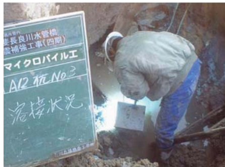
杭頭部材溶接状況
