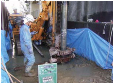
ケーシング引抜き状況
