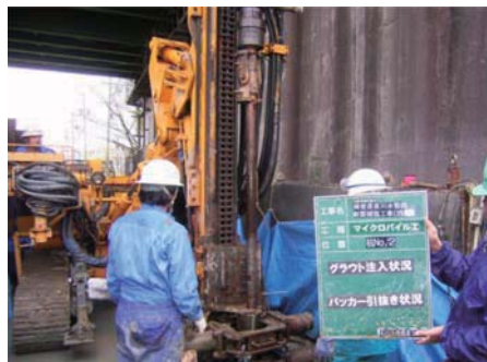
パッカー引抜き状況
