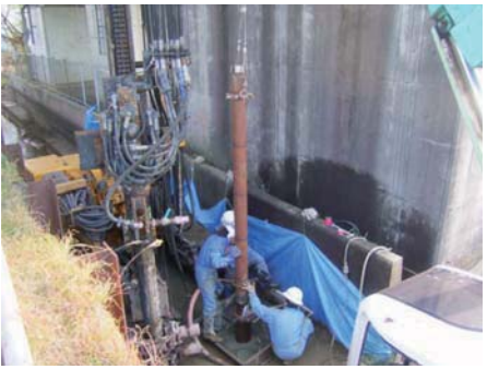
ケーシング内への鋼管挿入状況
