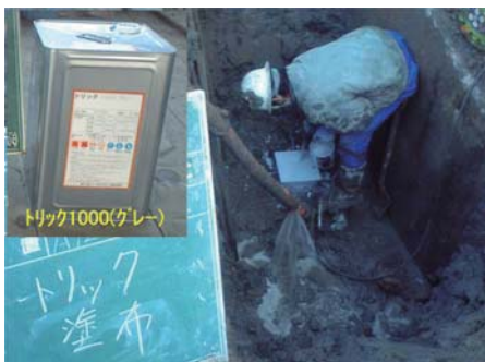
防錆材(トリック1000)塗布状況
