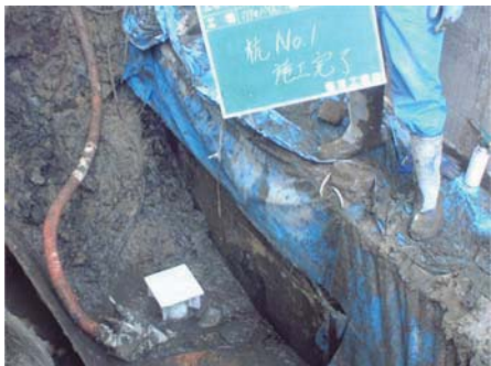
杭頭部養生完了
