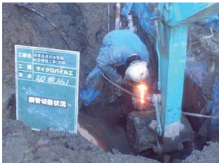
鋼管切断状況
