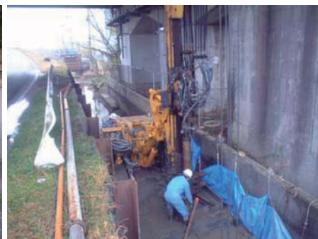
水路内での削孔状況
