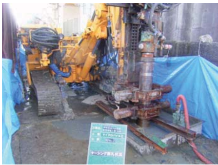
ケーシング削孔状況
