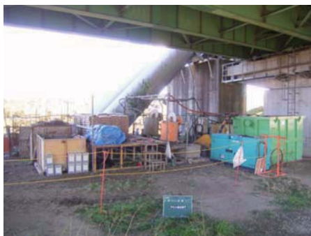
プラント設備全景
