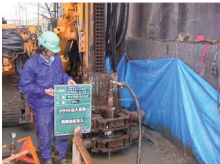
段階加圧注入状況
