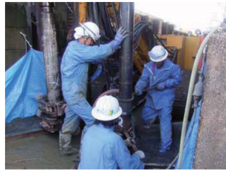
鋼管接続状況
