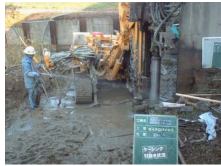
ケーシング引抜き状況
