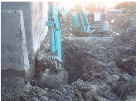
杭頭部掘削状況
