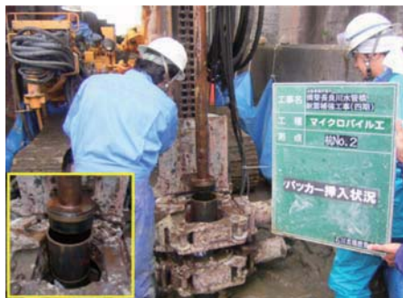
パッカー挿入状況
