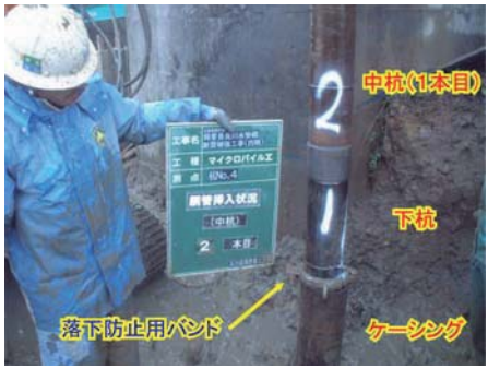
鋼管接続状況
