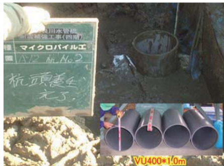
杭頭部養生状況
