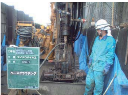
ベースグラウチング状況
