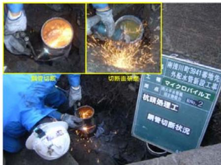
鋼管切断・研磨状況
