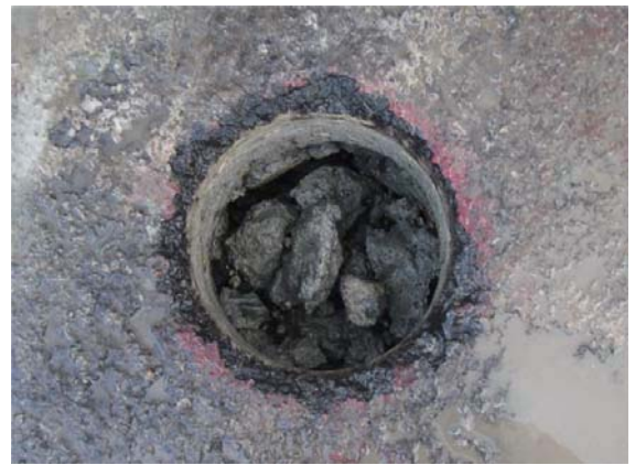
アスファルト舗装&均しコン削孔後
