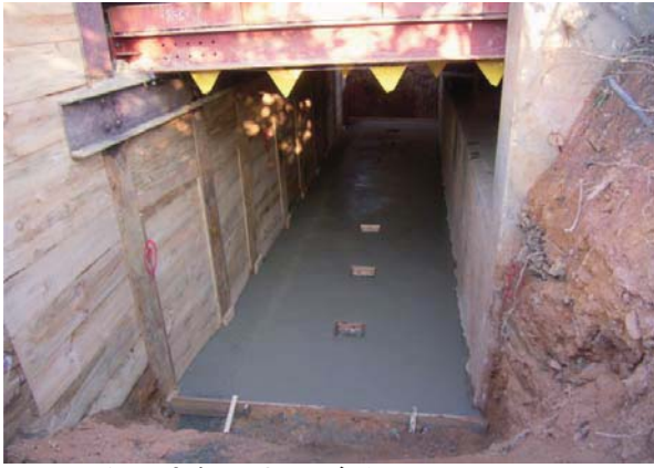
土留め支保工およびベースコンクリート
