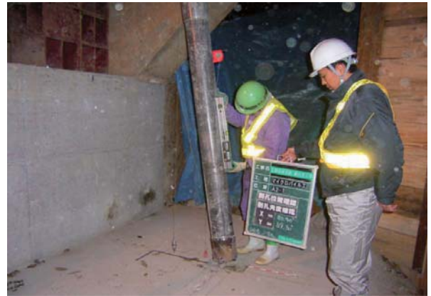
杭位置および角度確認状況
