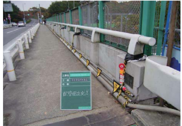
配管および防護状況
