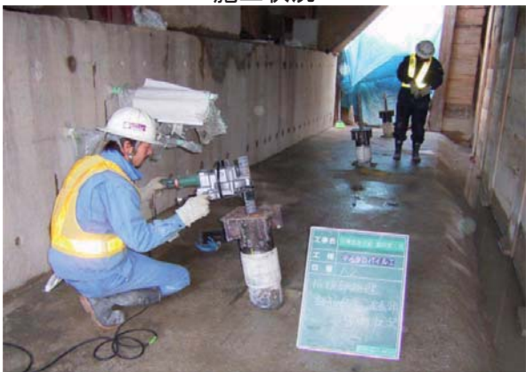
芯鉄筋切断状況
