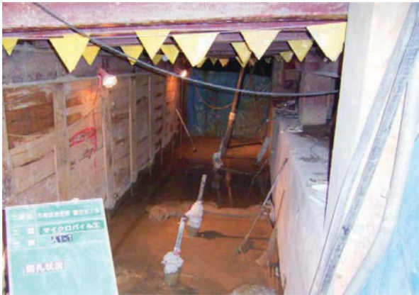
ヤットコ施工状況
