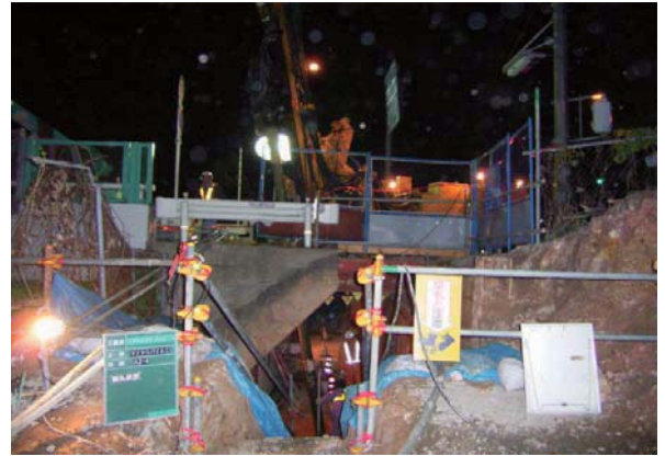
ヤットコ施工状況
