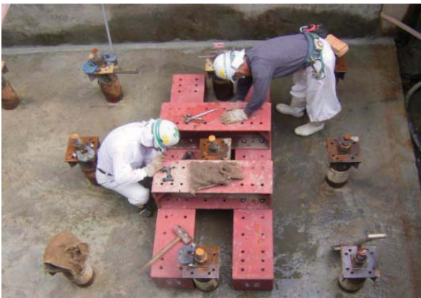
載荷装置組立状況
