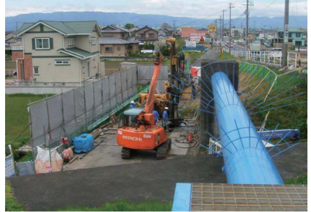
A2現場全景
