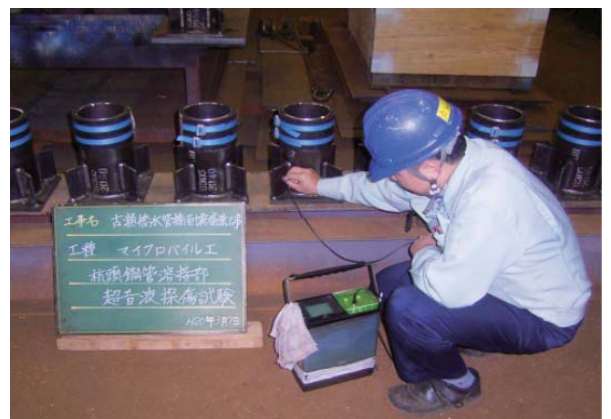
杭頭溶接部超音波探傷試験状況
