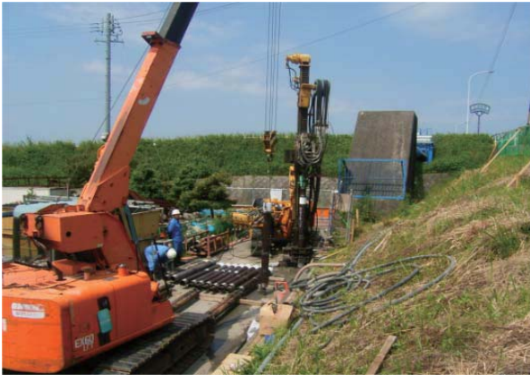
A1施工状況
