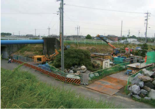
A1現場全景
