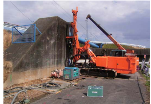
A2施工状況
