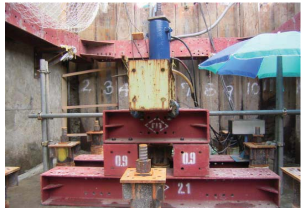
引抜き載荷試験状況
