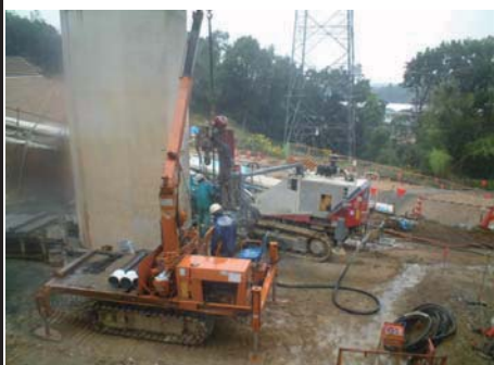
HMP施工状況
