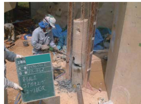
コア引抜き状況
