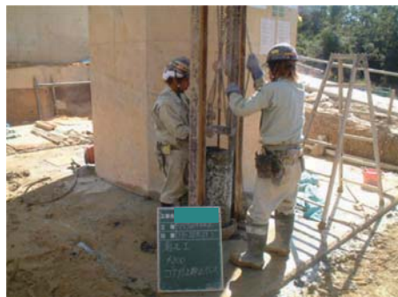
コア引抜き状況
