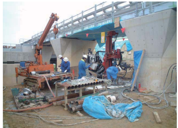
HMP施工状況
