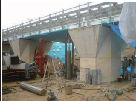
コア引抜き状況(全景)
