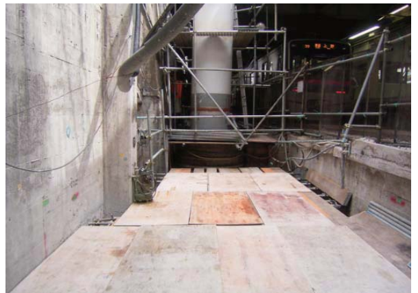
足場組立完了
