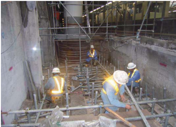
足場組立状況
