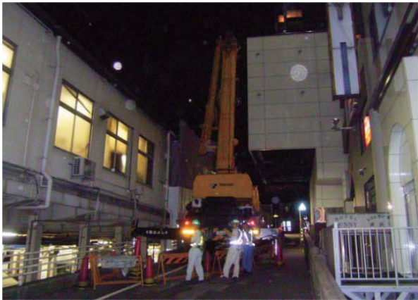
削孔機搬入状況(50t吊クレーン)
