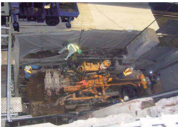
削孔機搬入状況
