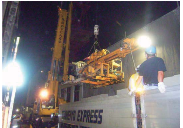
削孔機搬入状況
