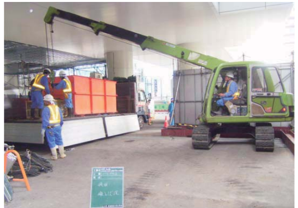
プラント組立状況
