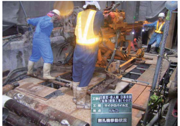
削孔機移動状況
