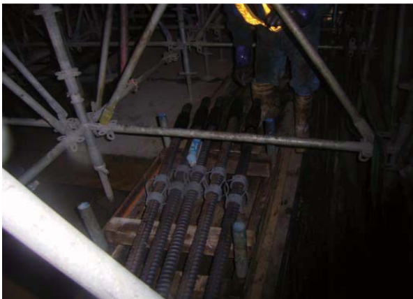
資材引込み状況
