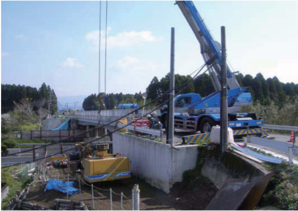
機材搬入状況(ボーリングマシン吊込み)
