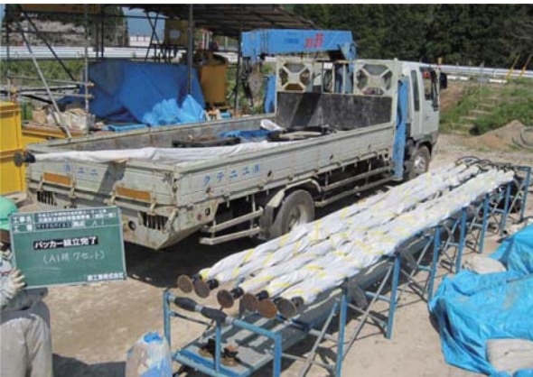
パッカー組立完了
