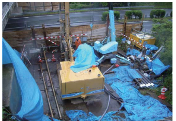
施工状況(A2)
