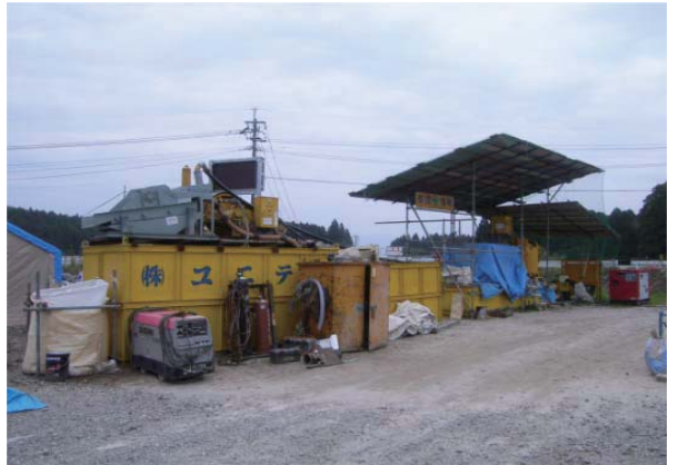
プラント設備
