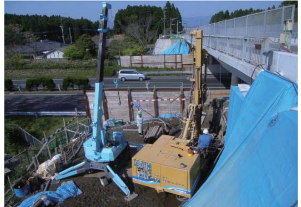
施工状況(A1)
