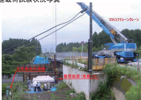
試験状況(全景)
