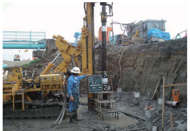
鋼管接続状況
