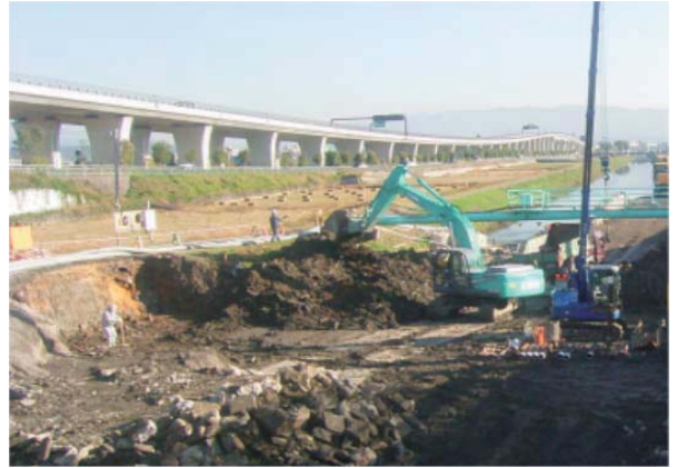
基面整地状況
