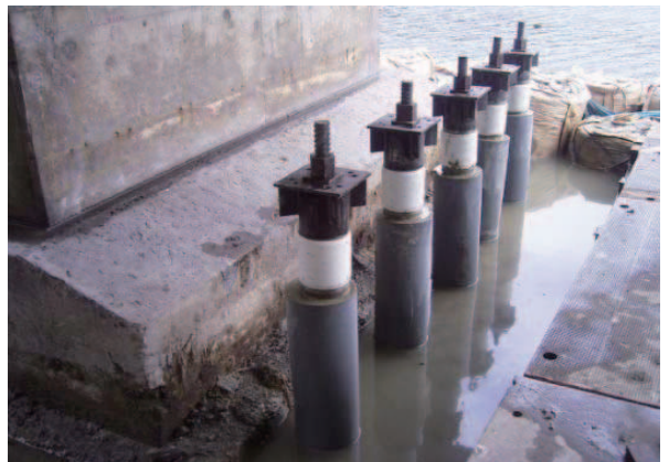
杭頭処理完了
