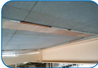
接合部型枠設置
