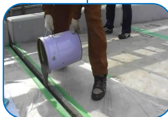
エポキシ樹脂モルタル充填
