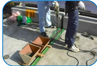
ポリマーセメントモルタル充填
