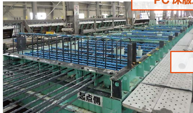
PC 床版工場製作
