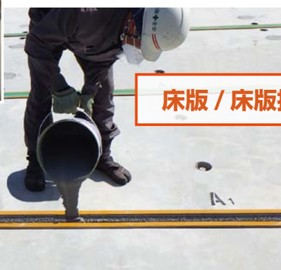
床版接合部へのELSS Joint (E) 用充填材施工
