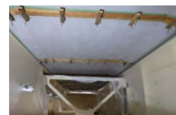
接合部型枠設置
