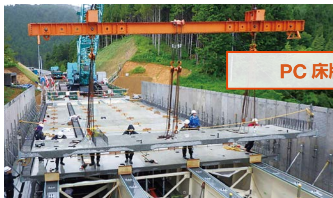
PC 床版架設
